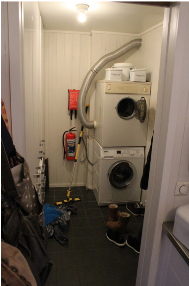
Figur 24 Bilde av kjelleretasjen - vaskerom
