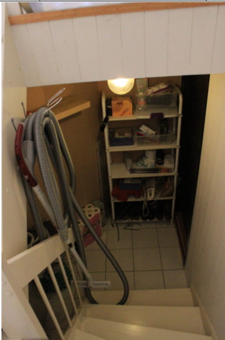
Figur 21 Bilde av kjelleretasjen
